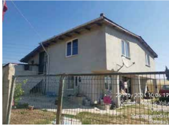
Çeşmeli Mah. 178 Ada 39 Parsel Ruhsatsız Yapı
