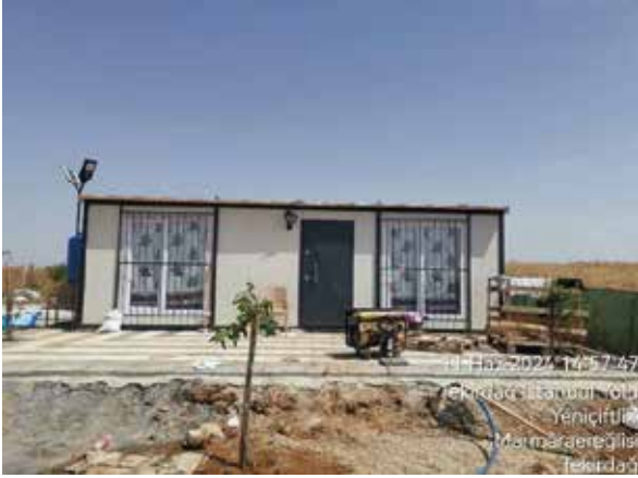
Dereağzı Mah. 1466 Ada 21 Parsel Ruhsatsız Yapı
