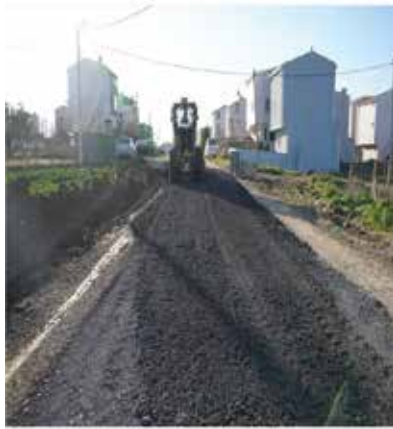
İlçe Geneli Asfalt Kaplama İşi.
