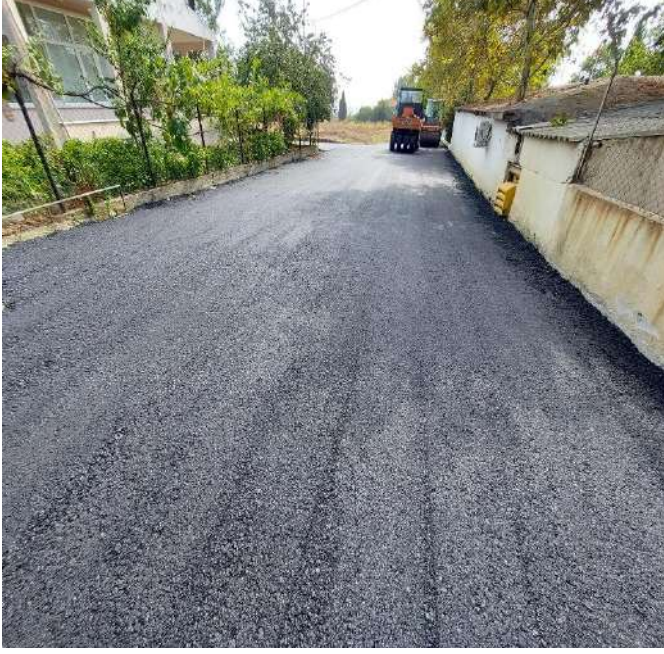
Asfalt Kaplama Yol Çalışması
