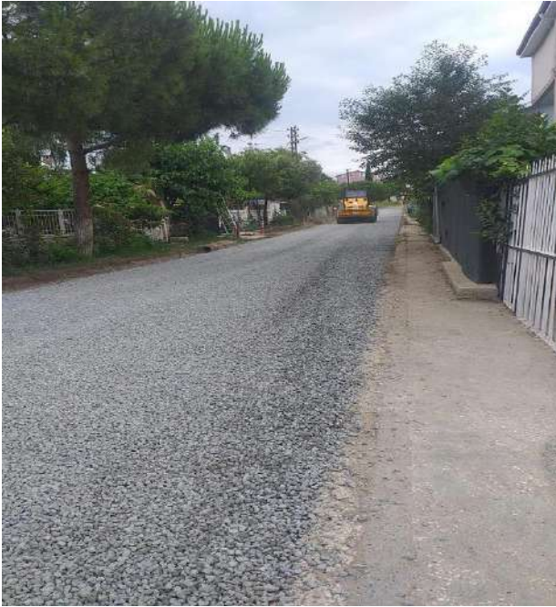
Sathi Kaplama (Soğuk Asfalt) Yol Çalışması
